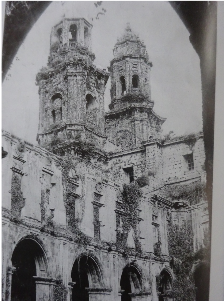
Vista das torres de Sobrado dos Monxes antes da restauración dos anos 60 do século XX.
